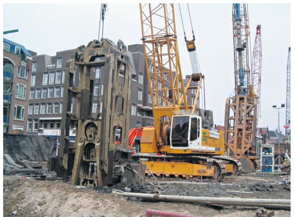
De bouwput die de Noord-Zuidlijn oplevert.
